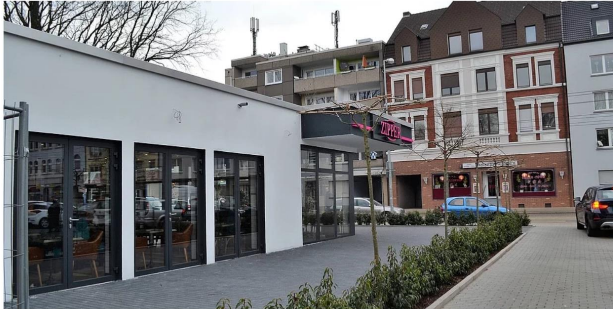
Eine Wasser-Wärmepumpe unterstützt von einem Eisspeicher beheizt die Bäckerei in Gelsenkirchen-Erle (Foto: Lara Blankenberg / EA.NRW)
